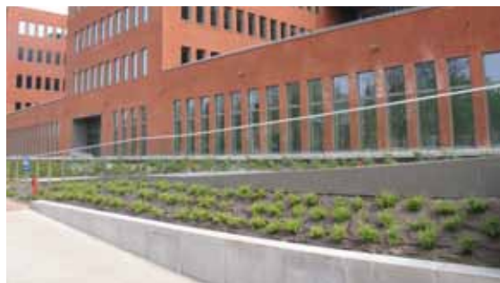
Referentie 09: Onderhoudsvrij en groen talud
