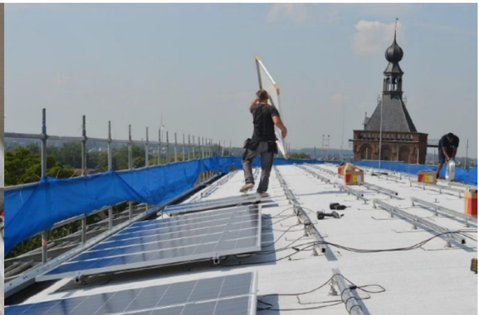
Installatie van zonnepanelen op het Stads kantoor.
