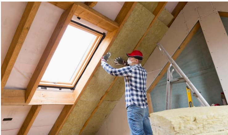
Het aanbrengen van dakisolatie
