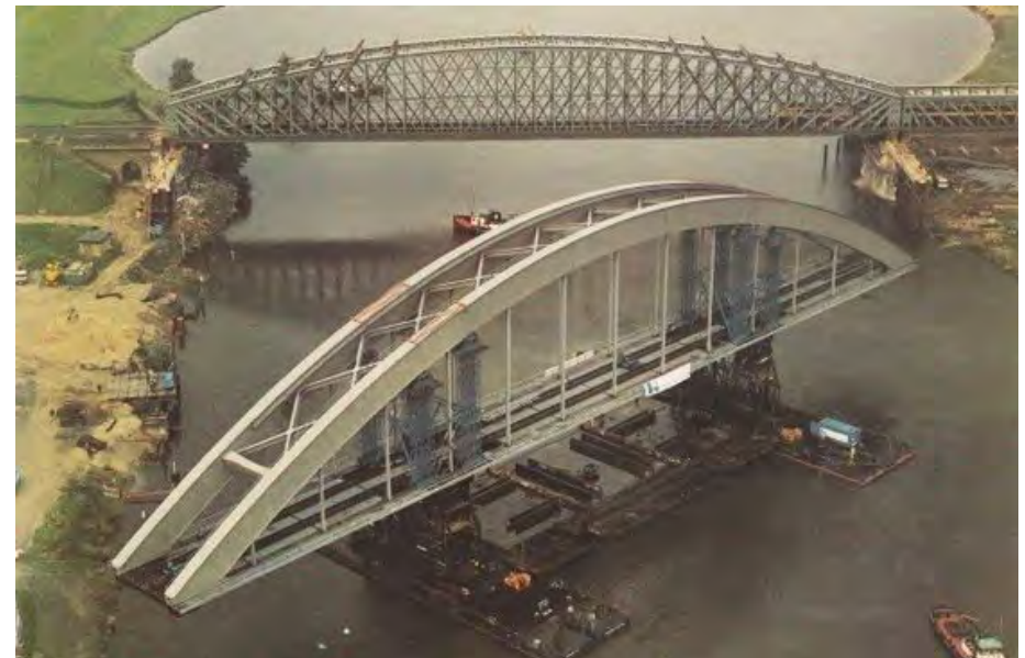
Nieuwe spoorbrug wordt geplaatst in 1982 beeldrecht: Culemborgs Genootschap AWK voet van Oudheusden, kortweg Voet
