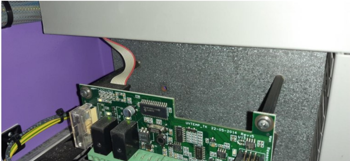
Figuur 5 Verborgen corrosie, let op schroefgat in het midden van de kast
