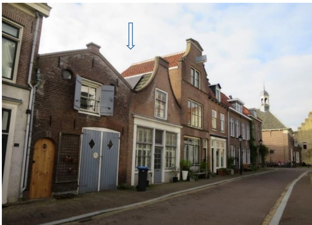
voorbeeld: zonnepanelen slechts beperkt zichtbaar op het zijdakvlak van een pand in een aaneengesloten straatwand
