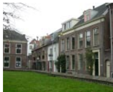
Staande gevelopeningen zorgen voor een duidelijke verticale geleding
