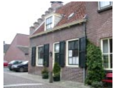
Gelijnde gevelopeningen en gevelbeeindiging zorgen voor horizontale geleiding
