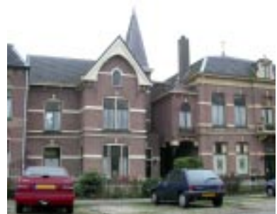
Bouwing langs het Voorburg is min of meer aaneengesloten
