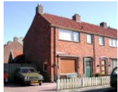
De bouwmassa heeft een eenvoudige opbouw van twee lagen met een zadeldak
