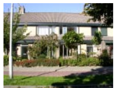
Op-, aan- en uitbouwen zijn in kleur en materiaal aangepast aan het hoofdgebouw
