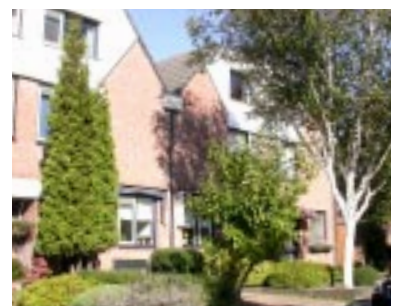
Samenhangend kleur- en materiaalgebruik
