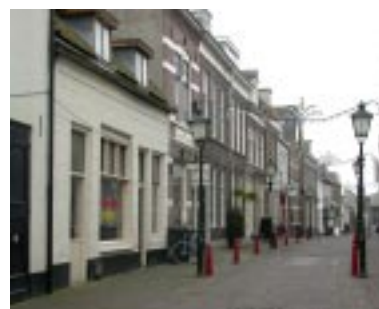
Gevarieerde bebouwing vormt het straatbeeld van de binnenstad
