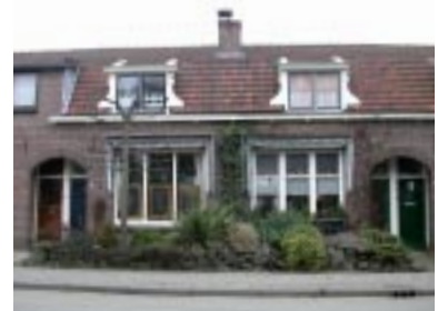
Bescheiden dakkapellen staan met de voet in de dakgoot
